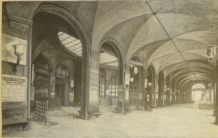
L'ANCIENNE GARE SAINT-LAZARE. — VESTIBULE DE LA BANLIEUE
