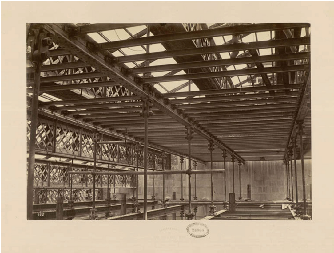
2.17. Louis-Émile Durandelle, Iron Girders of Stage Flytower, 1868. Albumen Print. École nationale supérieure des Beaux-Arts Ph 3810.
