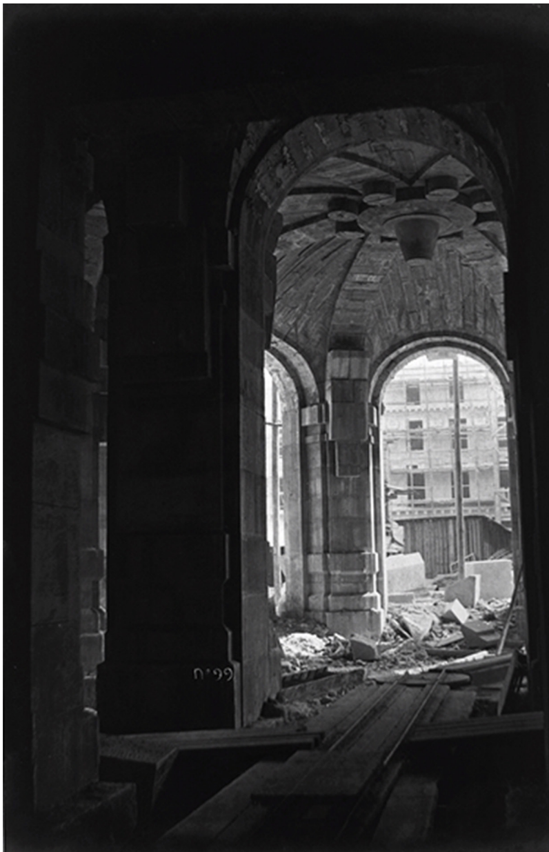
2.14. Louis-Émile Durandelle, Construction of the Nouvel Opéra, Paris, c. 1870. Albumen print. École nationale supérieure des Beaux-Arts Ph 7449.
