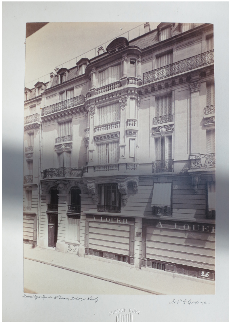
5.7. Apartment Building, rue du Général Henrion Berthier, Neuilly. Gustave Gridaine, architect. Albumen silver print. In Albert Lévy, Les Constructions nouvelles: Maisons de rapport, hôtels privés : album photographique (Paris: E. Ducher, c. 1895), plate 26. Collection Centre Canadien d'Architecture/Canadian Centre for Architecture, Montréal PH1981:0234:001-035. Photograph by Peter Sealy.
