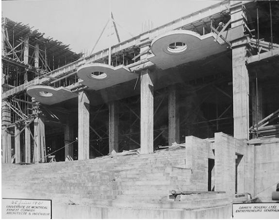
Figure 6.32 A photo of the construction of the reinforced concrete canopies over the main doors to the main pavilion, dated June 25, 1931. Source: [S. J. Hayward], P.1855, “Perron principal de l’aile L. Marquises au dessus des entrées. À l’extérieur gauche partie de l’aile H 8 ,” box 02-2402-01P, FEC, CCA.
