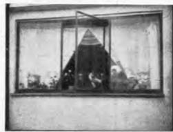
Bild 70. Drehflügel und Flügelfeststeller.
