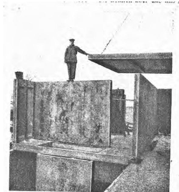
Abb. 11. Versetzen der Deckenplatte auf die gerippten Wandplatten.
