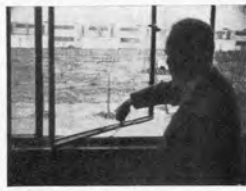
Bild 68. Ausstellband und Flügelfeststeller.
