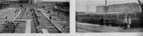
Abb. 4. Auf einer Tagelohnarbeit an verschiedenen Arbeitsplätzen für die Eisenbetonwerke.
